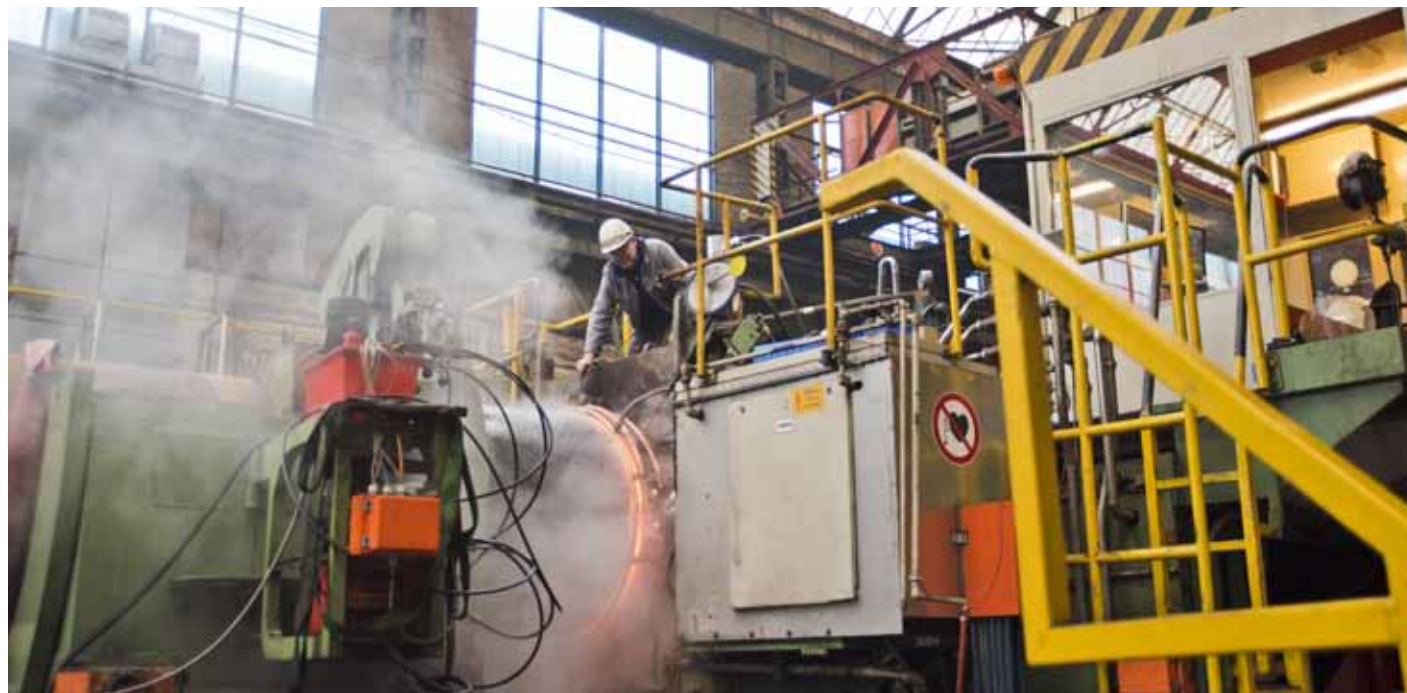
Die Rohre werden im Rohrbiegewerk induktiv gebogen – in verschiedensten Winkeln
